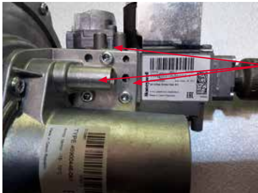
Photon 10-70 bevestigingsschroeven gaskleppen
