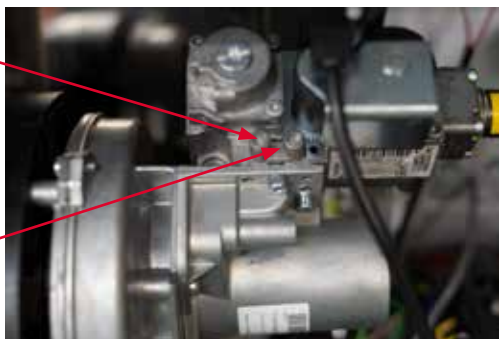
Gasdruktestpunten Photon 10-70
