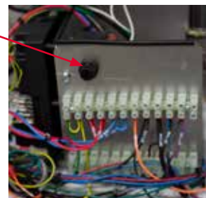
Przełącznik resetu LC3 Photon 25-100
