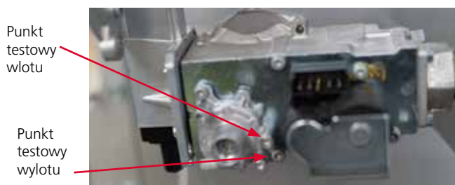
Punkty prób ciśnieniowych gazu dla Photon 100
