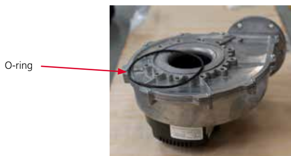
Photon 100-120 combustion fan
