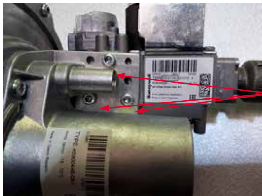
Śruby mocujące zaworu gazowego Photon 10-70
