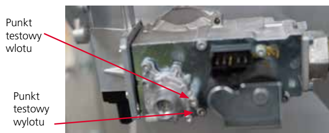
Punkty prób ciśnieniowych gazu dla Photon 100
