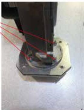
6. Fixez le joint neuf sur la bride de sortie du ventilateur (tous les modèles) et montez la plaque de montage (modèles 10-70 uniquement)
