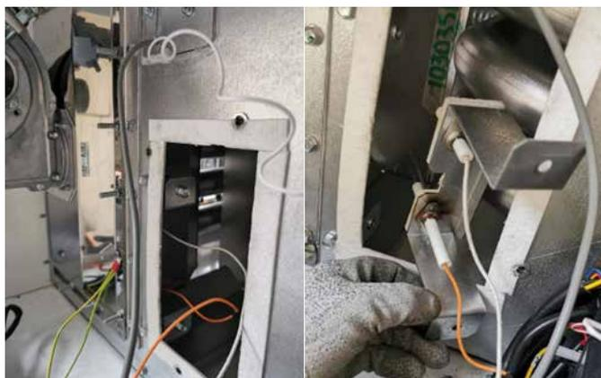
7. Placez soigneusement les deux joints de sonde de remplacement dans le kit de sonde de remplacement sur le support de l'ensemble de sonde avant de le remettre en place sur l'unité.
