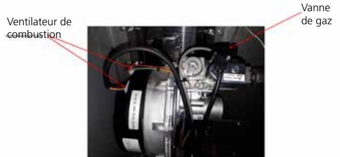
2. Débranchez le raccord union d'alimentation en gaz à l'intérieur de l'ébénisterie et dévissez le tuyau de gaz.
