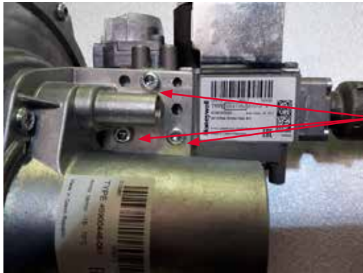
Photon 10-70 Gasventil-Befestigungsschrauben
