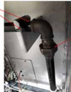
3. Desatornille las tuercas de 8 mm exteriores que aseguran el ventilador de combustión al quemador.
