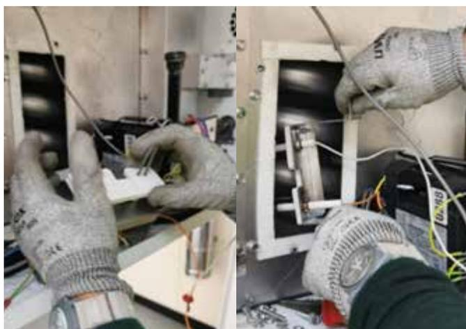
8. Instale el soporte de la sonda de repuesto en el costado de la cámara de combustión utilizando los pernos de retención de 10 mm..
