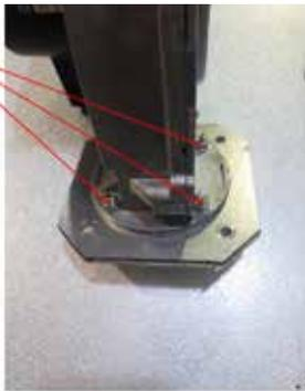
6. Neue Dichtung am Gebläseauslassflansch anbringen (alle Modelle) und Trägerplatte montieren (nur Modelle 10-70)
