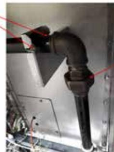
3. Die äußeren 8-mm-Muttern, mit denen das Verbrennungsgebläse am Brenner befestigt ist, lösen.
