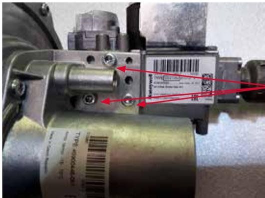
3 Befestigungsschrauben entfernen
