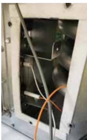
9. Überprüfen Sie, ob die Ersatzdichtungen flach auf der Brennkammer aufliegen und keine Anzeichen von Beschädigungen aufweisen.
