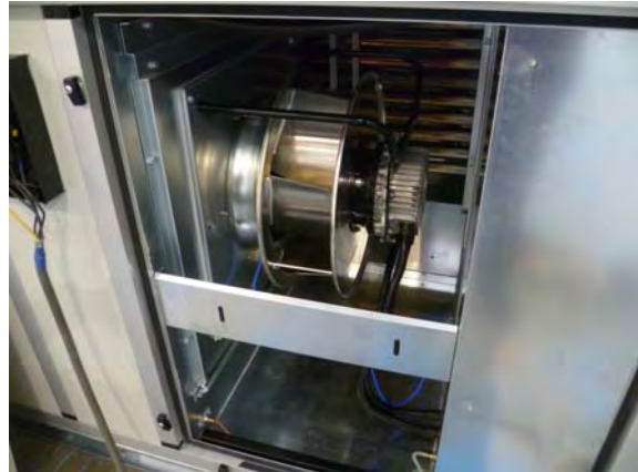
EBM fan arrangement in IDF2—IDF3
