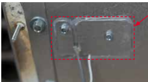
Siliconenkit rond montagebeugel
