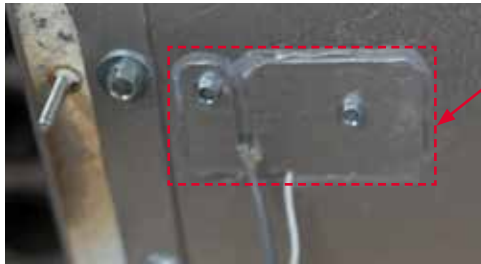
Joint en silicone autour du support de montage
