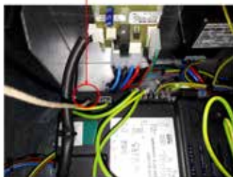
Sonde de détection de flamme
