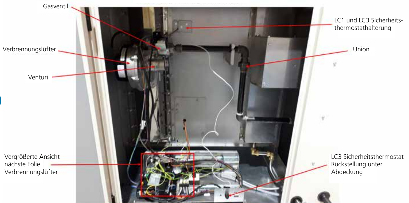
Modell 25-70 Komponenten-Layout
