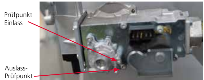
Gasdruckprüfpunkte PREEVA Neos 100
